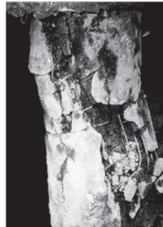
杭頭を剛接した杭の被害例
