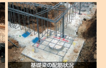
基礎梁の配筋状況
