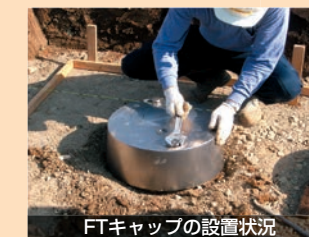
FTキャップの設置状況
