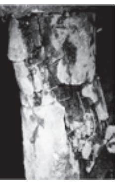
杭頭を剛接した杭の被害例
